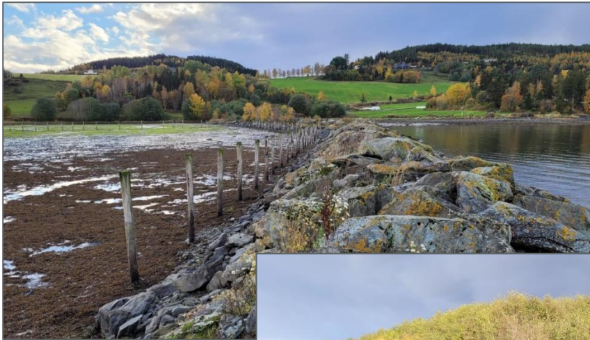
Figur 3-3: Moloene som ble etablert som beskyttelse for tømmerhavna består av grov stein, og er lite tilgjengelig for ferdsel og dyreliv (Norconsult)
