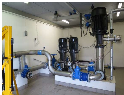
Figur 2 Hagle trykkøkingsstasjon og innvendig Røstadlia trykkøkingsstasjon
