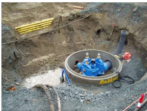
Figur 3 Ny vannkum i sentrum (bilde 1) og gammelt trerør som førte vann til Levanger (bilde 2)
