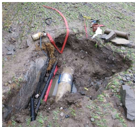
Figur 5 Lekkasje på vannledninger (bilde 1) og reparasjon av vannledning (bilde 2)
