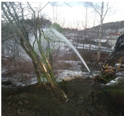
Figur 5 Lekkasje på vannledninger (bilde 1) og reparasjon av vannledning (bilde 2)
