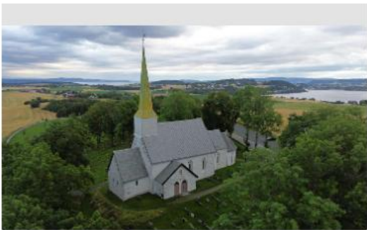
DJI_0954.JPG 1.1 Yttertak og tårn
