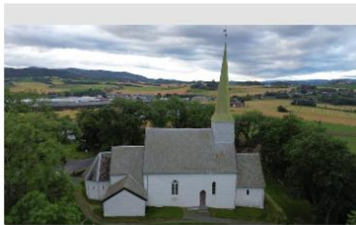
DJI_0951.JPG 1.1 Yttertak og tårn
