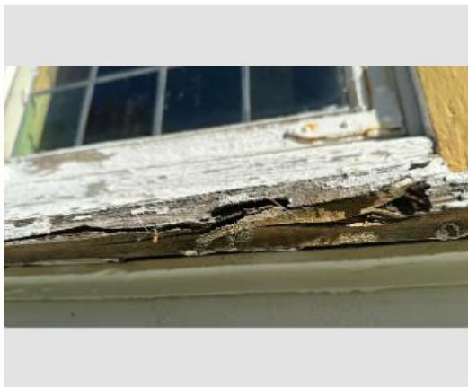
MOB_20250902_102310(0).jpeg 3.4 Har kirka vinduer hvor det er fukt/råte i sprosser eller karm?
