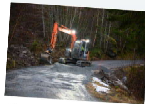
Gravemaskin i sving med å reparere skadene på Bergbygdavegen torsdag,
