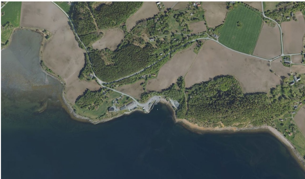
Figur 7 Oversiktsbilde som viser dagens arealbruk ved Hokstad ferjekai, med ferjeanlegg i strandsonen, tilhørende adkomstveg og omkringliggende jordbruks- og boligområder. Kilde: Norgeskart.
