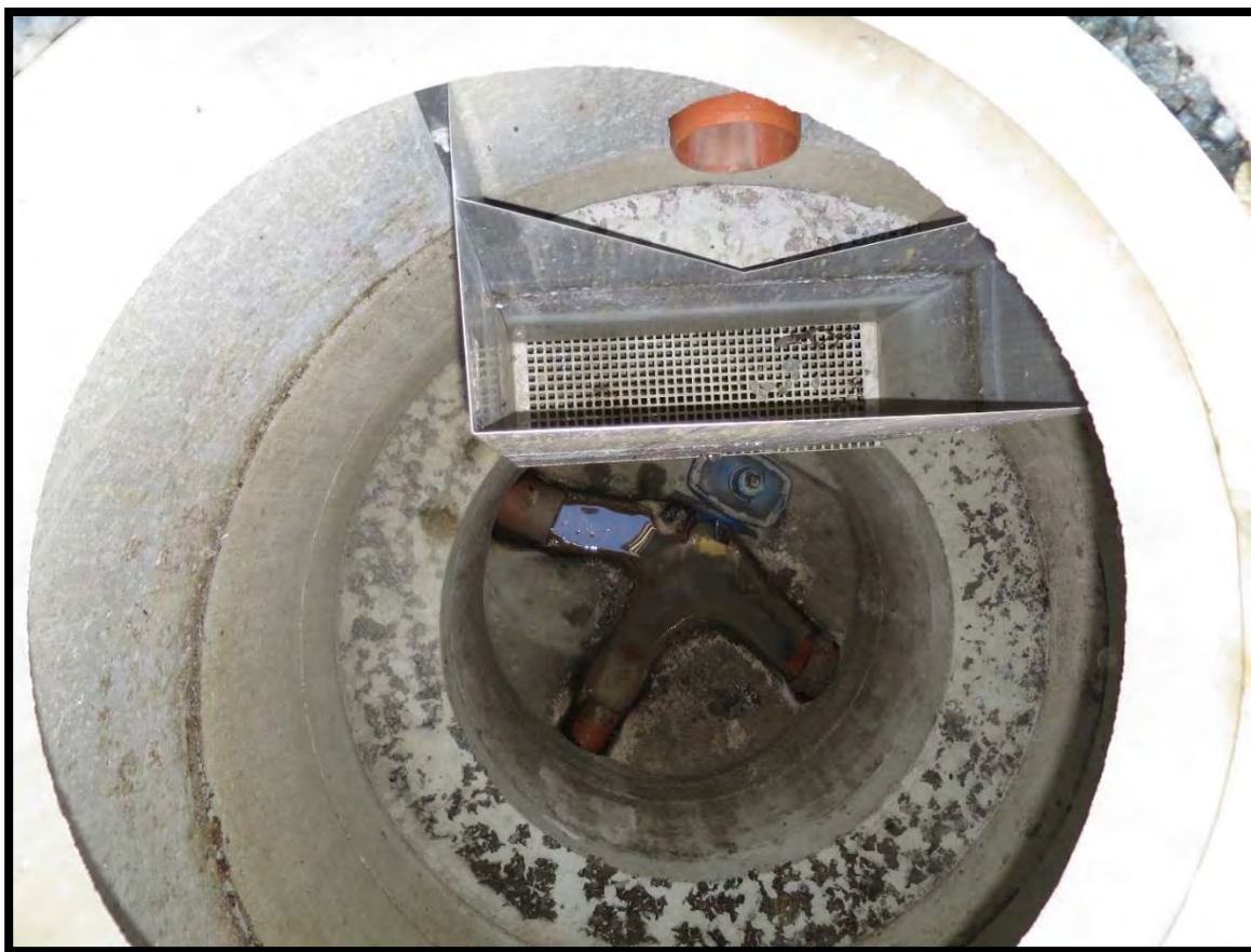
Figur 6 Overløp fra kum med rist og skumskjerm
