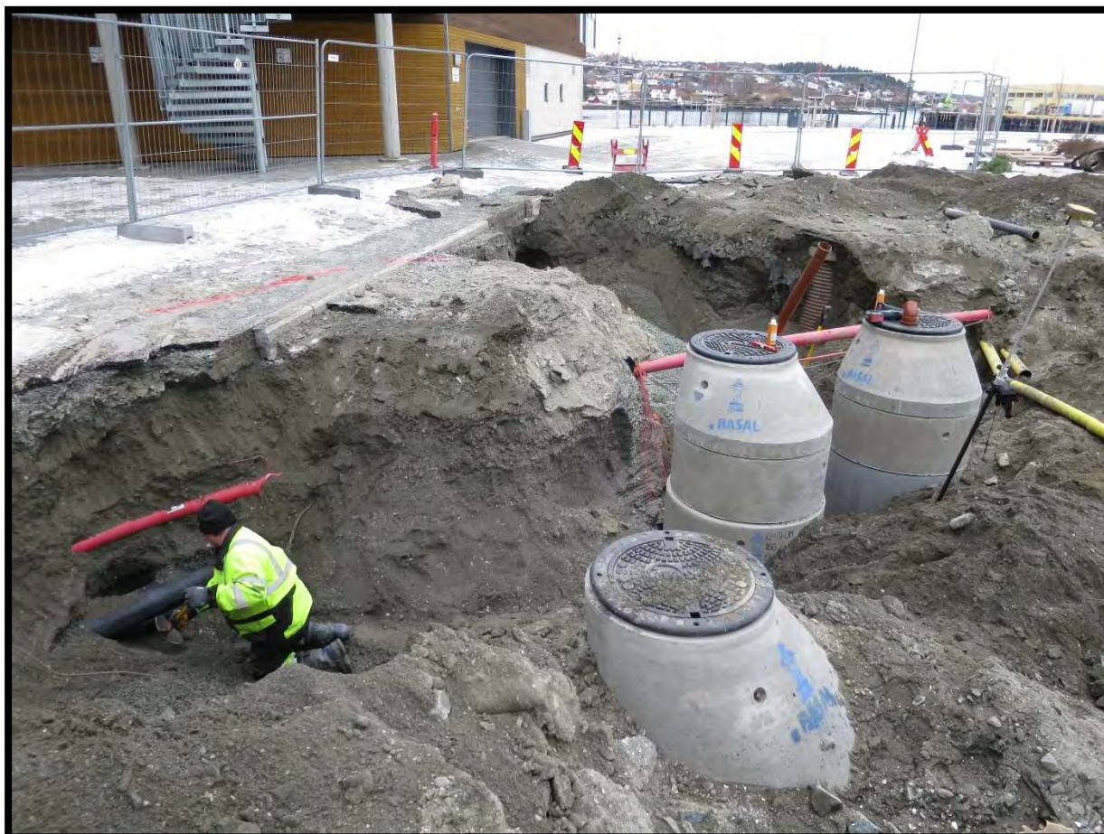
Figur 5 Eksempel på arbeid med ledningsanlegg
