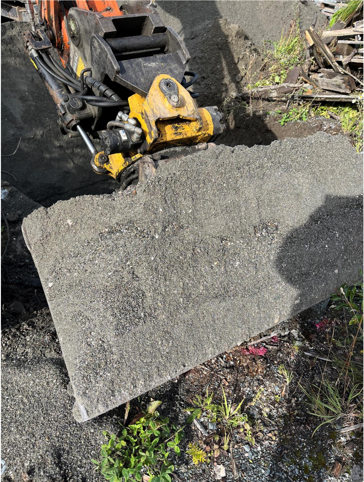
Hull to: Sand som er hentet fra bunnen av hullet inneholder skjell. Tyder på at dette er sjøbunn som er mudret inn i det oppfylte området. Ensartede masser nedover i hullet.
