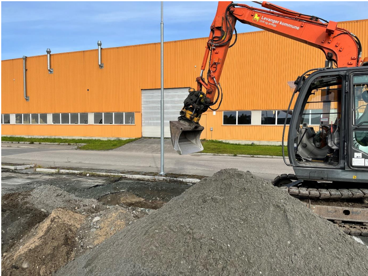
Hull 1: På parkeringsplassen ved Vaskeriet. Asfalt og sand i øverste lag.
