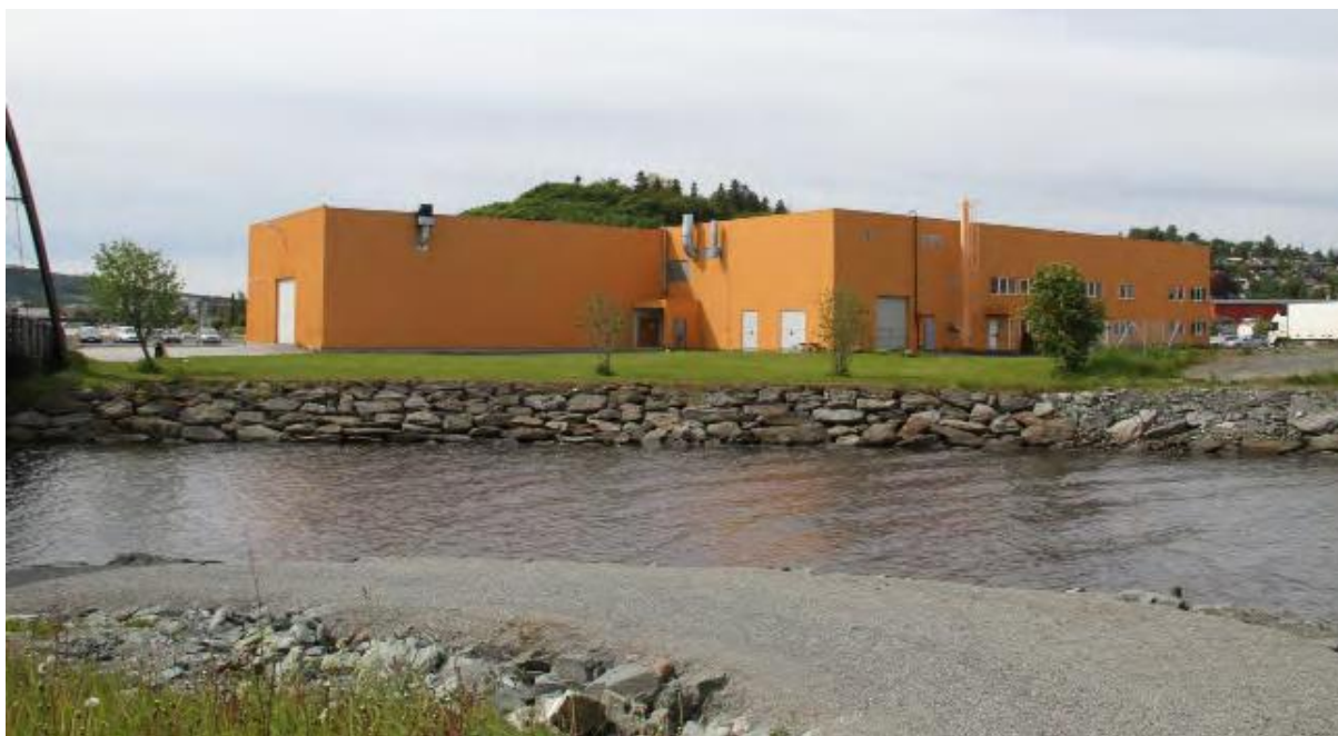
Bilde 3: Bilde av tidligere vaskeri sett fra øst og med elva i forgrunnen. Kilde: Mulighetsstudie av Tidligere vaskeri på Levanger Havn (Foto: Tove Nordgård).
