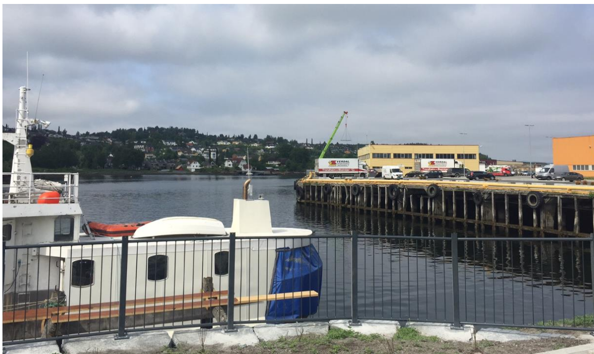
Bilde 4: Bilde tatt fra indre havn og mot eksisterende sjøkant ved Skald Ravns plass. Kilde: Norconsult.
