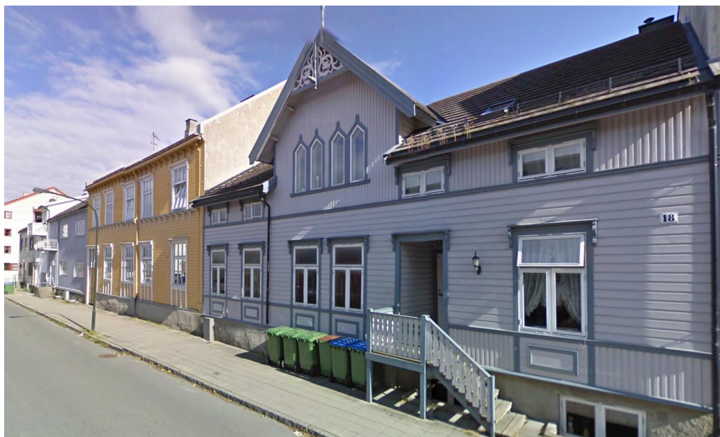
Figur 17: Eksempel på avfallsdunker plassert tett inntil brennbar fasade.
