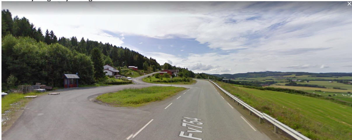
Figur 5: Google gatebilder som viser innkjøring til Bjørnangveien fra Fv 754.
