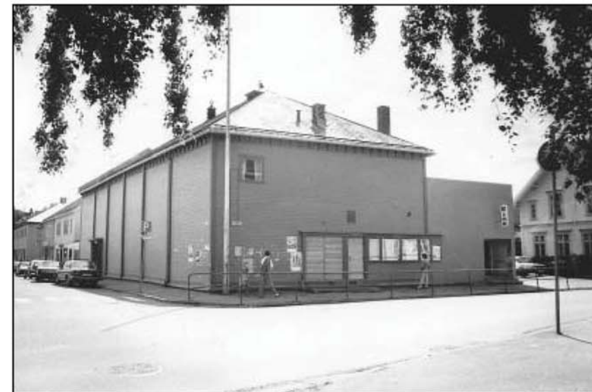
1949: Slik så kinoen ut etter ombyggingen i 1949.
